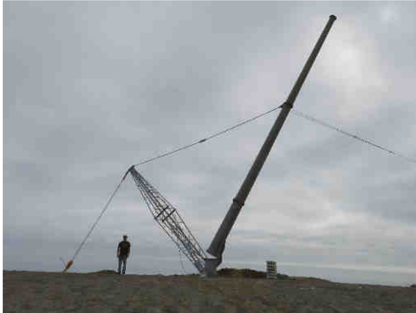
Torre de 16 m con maniobra que no requiere de grúa
