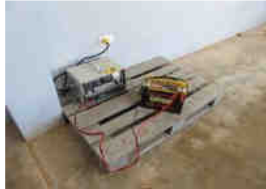
Centro de carga de baterías para las embarcaciones
