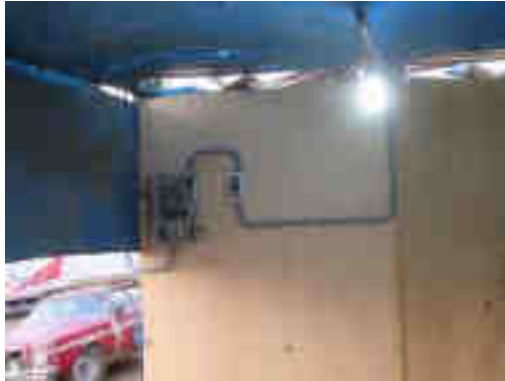
Instalación de 35 suministros para viviendas y negocios
