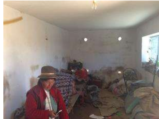
Aislamiento con techo arpillero
