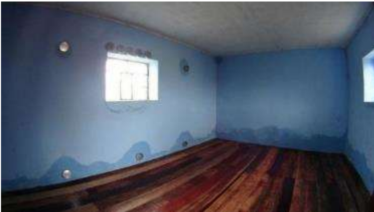
Aislamiento de Piso
